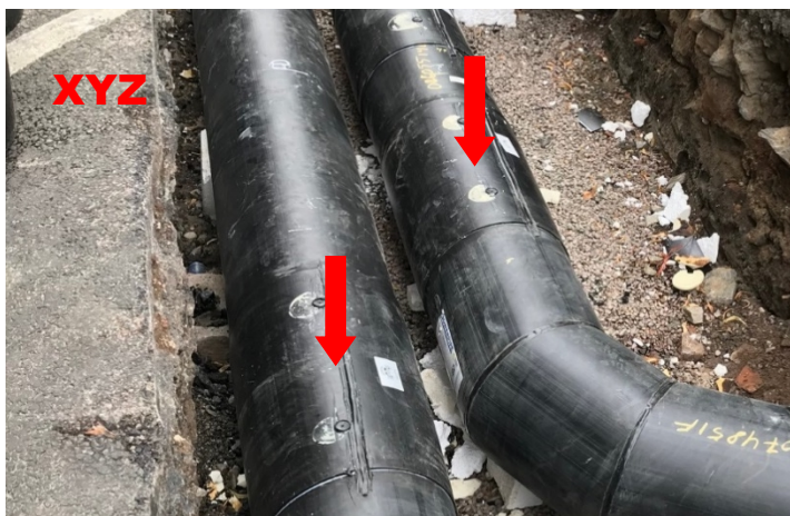
Svetsade skarvar, ej skummade. Kompensera Z-höjden så den avser isolerad ledningshöjd.
