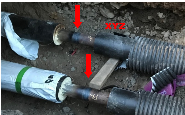
Svetsade skarvar, ej skummade. Kompensera Z-höjden så den avser isolerad ledningshöjd.
